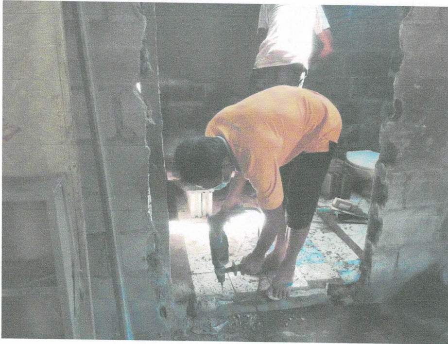
ระยะที่ ๒ ภาพระหว่างดำเนินการปรับปรุง/ซ่อมแซม
