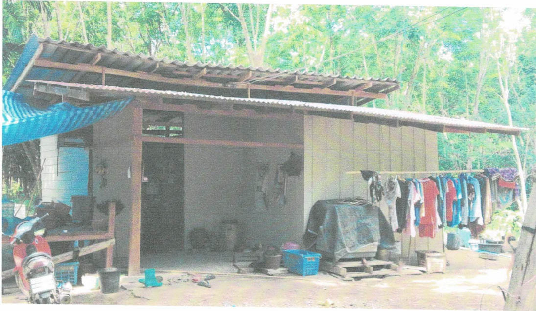
ระยะที่ ๓ ภาพดำเนินการปรับปรุง/ซ่อมแซมแล้วเสร็จ
