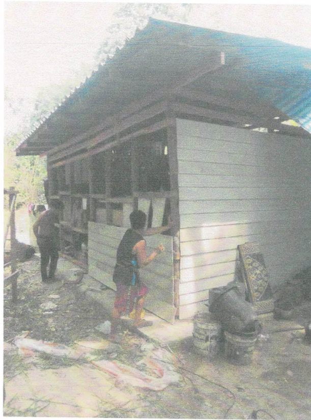
ระยะที่ ๒ ภาพระหว่างดำเนินการปรับปรุง/ซ่อมแซม
